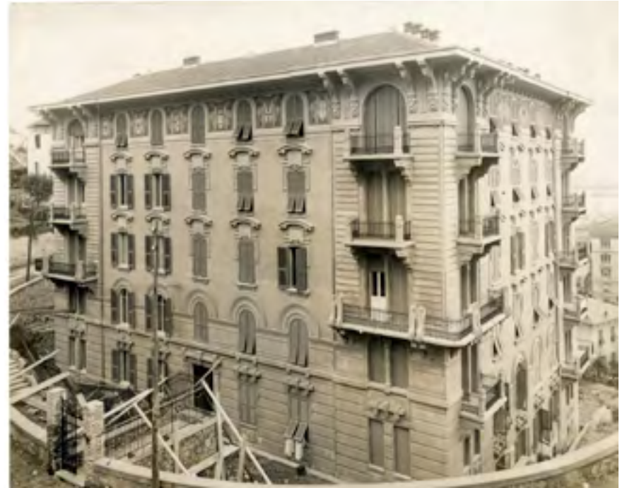
Uno dei palazzi della Fondegia in fase di edificazione
